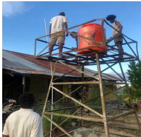
Gambar 6. Pemasangan Tandon Air dan instalasi filtrasi
