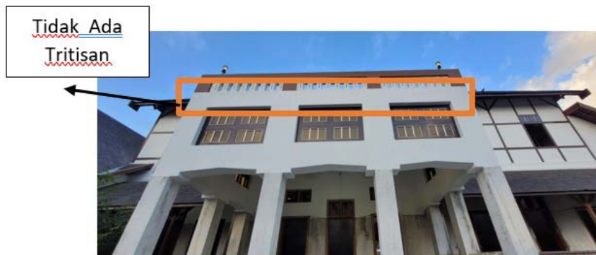
Gambar 7. Pengurangan Tritisan Istana Bala Putih Sesudah Direstorasi Sumber: Suarantb.com,2017
