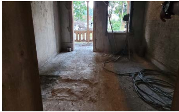
Gambar 3. Bekas Toilet Yang Dibongkar Sumber: Data Pribadi,2022
